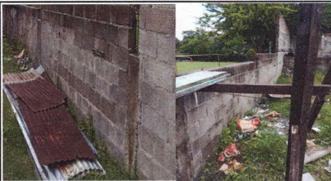
MURO PERIMETRAL Y REPARACIÓN Y REFORZAMIENTO DE COLUMNAS
