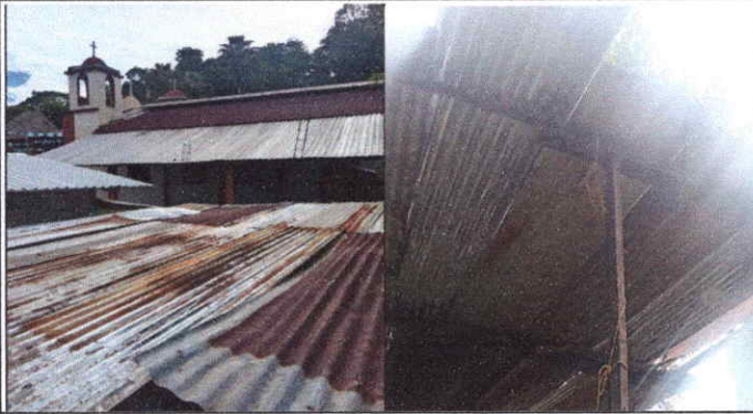
SUSTITUCION DE LAMINA POR LAMINA TROQUELADA ALUZINC Y ESTRUCTURA DE TECHO DE SOPORTE DE MADERA POR METAL
