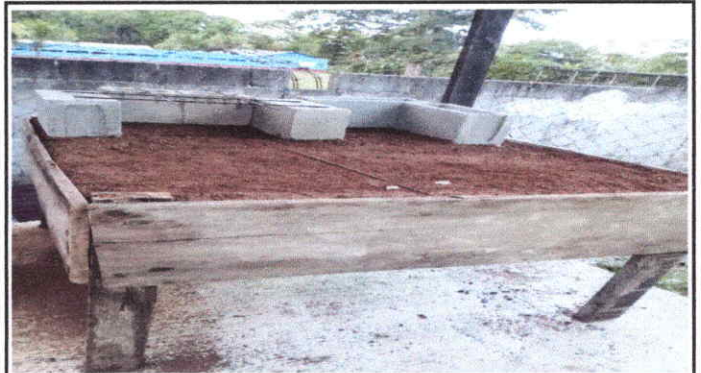
REPARACION DE COCINA: SUSTITUCION POR ESTUFA RURAL (COMPLETA INCLUYE CHIMENEA Y DOS PLANCHAS DE METAL CON MESON)
