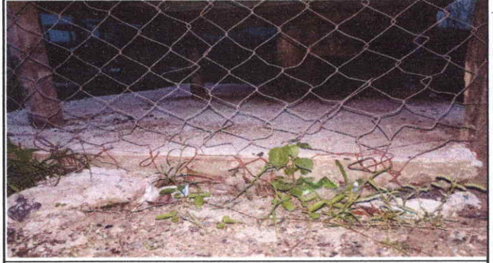
SUSTITUCION DE PISO DE CONCRETO
