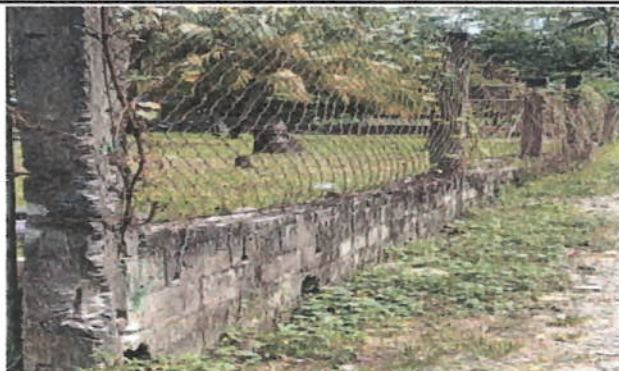
Foto 1: Reparación de muro perimetral de block con tubo hg y malla galvanizada y columnas de concreto, repello en muro
