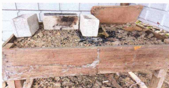
Foto 3: Sustrucción de estufa rural (completa) incluye chimenea y plancha de metal
