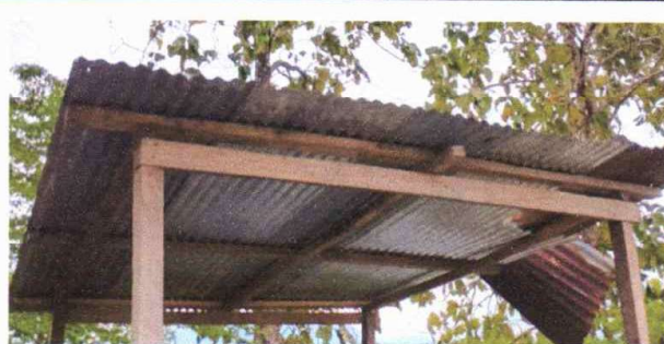
Foto 2: Sustrucción de estructura de soporte de madera, por metal
