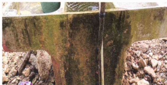
Foto 4: Sustrucción de pila de cemento de dos lavadero
