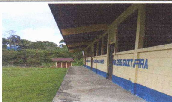
Foto 4: Pintura en muros exteriores e interiores
