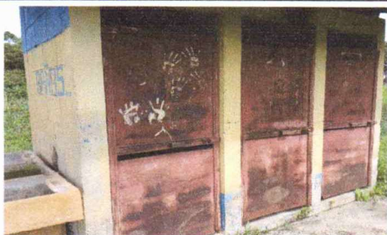
Foto 5: Mantenimiento a estructura (lijado, cambio de tubo , cepillado, sujeciones, aplicación de pintura) a puertas servicios sanitarios
