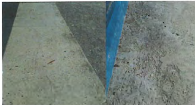
Foto 4: Sustitución de torta de cemento.
