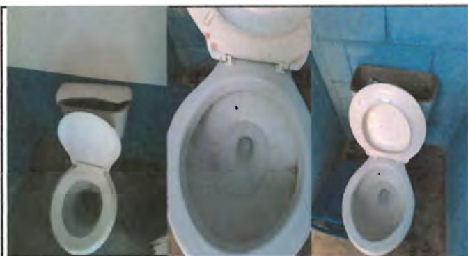
Foto 3: Sustitución de Inodoros completos
