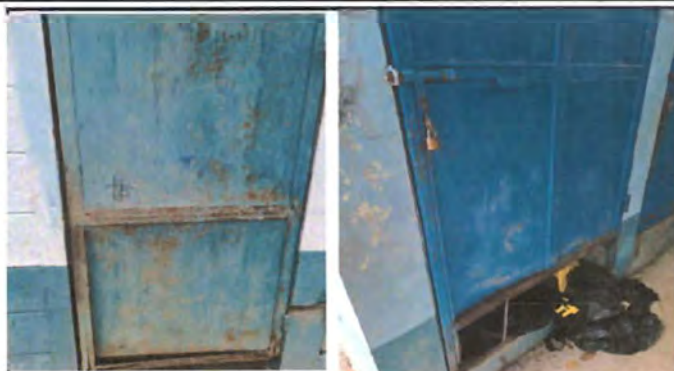
Foto 2: Sustitución de Puerta de metal en baños
