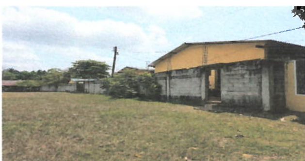
Foto 4: Reparación de muro perimetral de block
