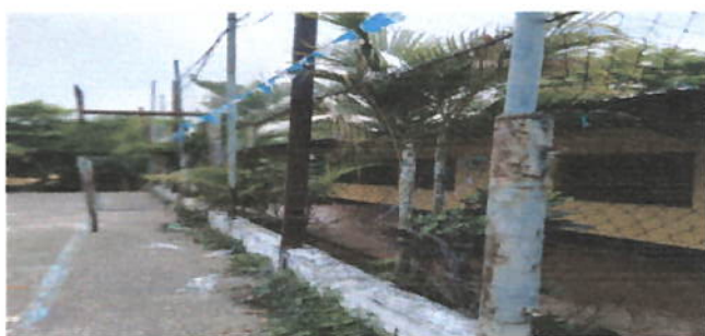
Foto 5: Reparación de tubo hg y malla galvanizada
