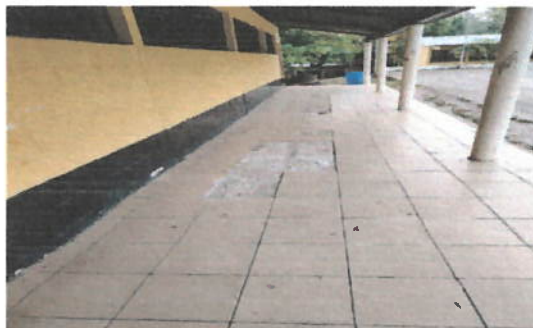
Foto 2: Sustitución de piso cerámico
