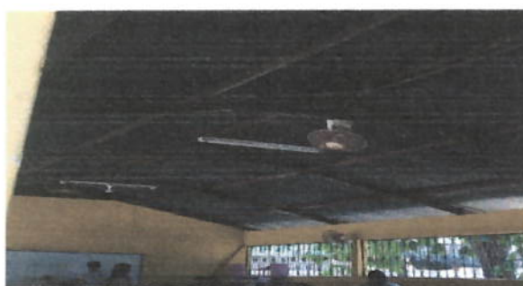
Foto 6: Reparación de Sistema Eléctrico
