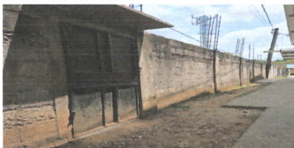
Foto 9: : Repello en muro
