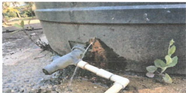
Foto 7: Sustitución de depósito de agua 1100 lt
