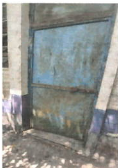
Foto 1: Mantenimiento a estructura (lijado, cambio de tubo, cepillado, sujeciones, aplicación de pintura)
