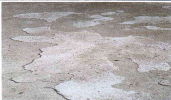
Foto 5: Reparación de piso de torta de concreto
