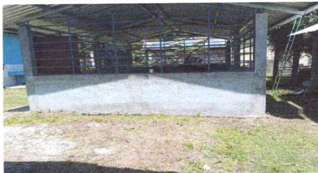
Foto 3: Pintura en muros exteriores e interiores
