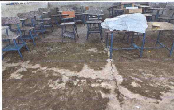
Foto 3: Sustrución de piso de cemento liquido a granito
