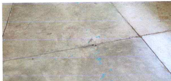
Foto 2: Sustrución de piso de cemento liquido a piso cerámico a Dirección.
