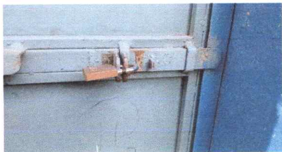
Foto 3: Sustrución de chapa
