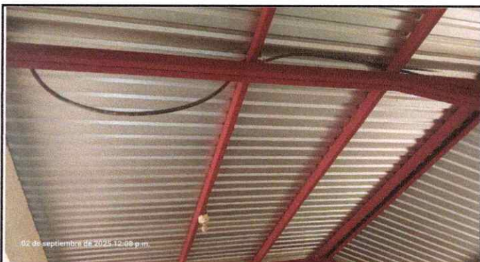
Foto 9: Sustitución de ducto + accesorios en todas las aulas.
