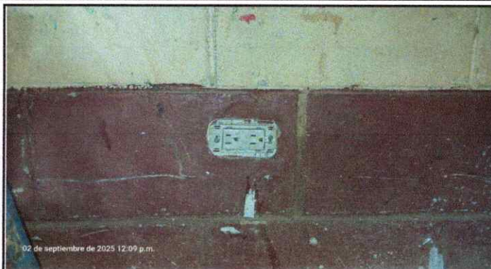
Foto 7: Sustitución de tomacorrientes dobles en todas las aulas.
