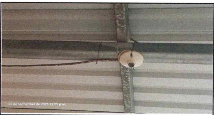
Foto 5: Sustitución de plafoneras en todas las aulas.
