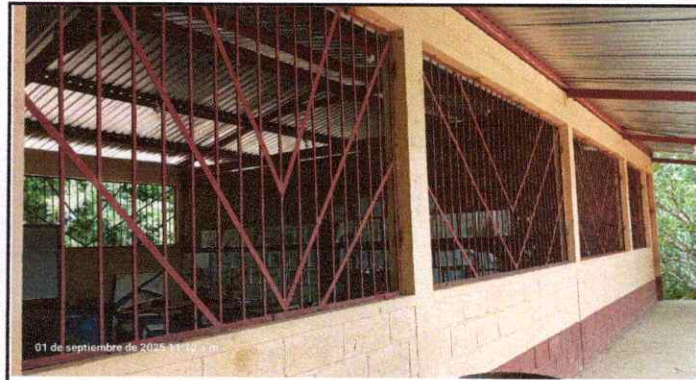
Foto 1: Mantenimiento de balcones de metal de todas las aulas.
