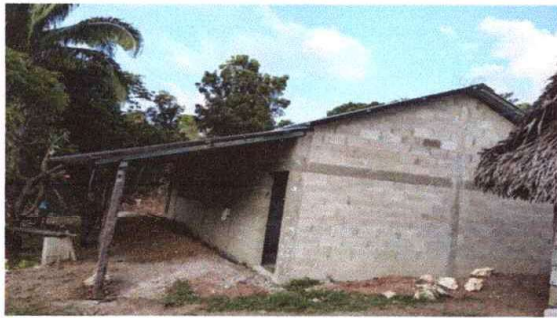
FINALIZACIÓN DE REMOZAMIENTO DE PAREDES
