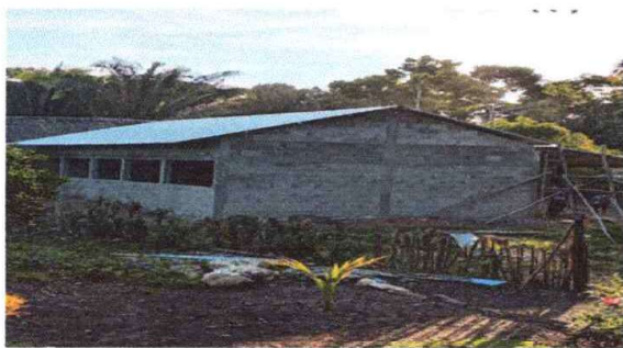
FINALIZACIÓN DE COLOCACIÓN DE TECHO
