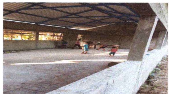
FINALIZACIÓN DE PISOS CERAMICO
