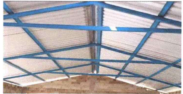
FINALIZACIÓN DE COLOCACIÓN DE ESTRUCTURA METAL
