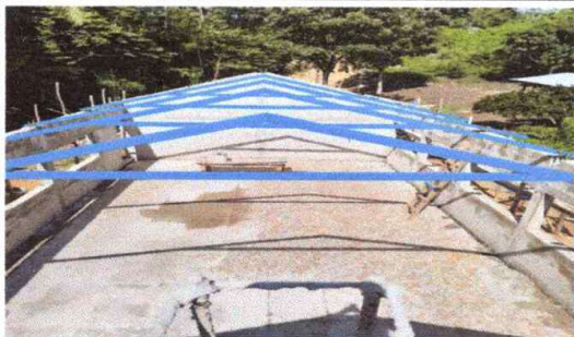
REMOZAMIENTO DE VIGAS
