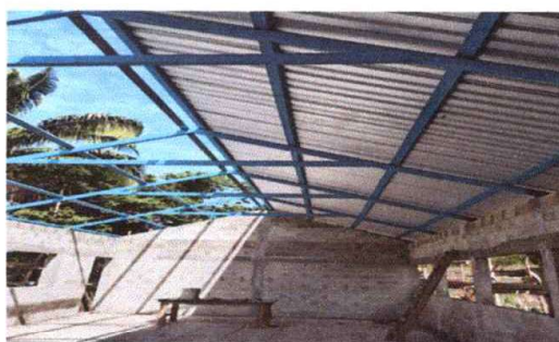
REMOZAMIENTO DE TECHO DE AULAS DE CLASES
