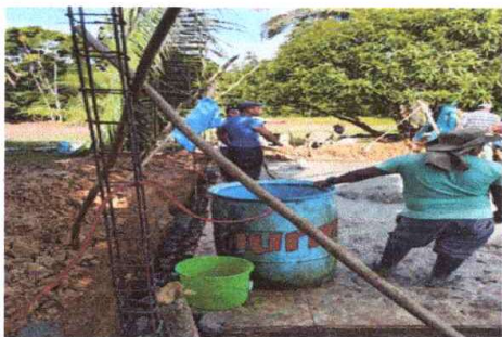
REMOZAMIENTO DE HORCONES
