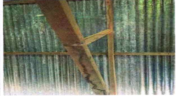
REMOZAMIENTO DE VIGAS
