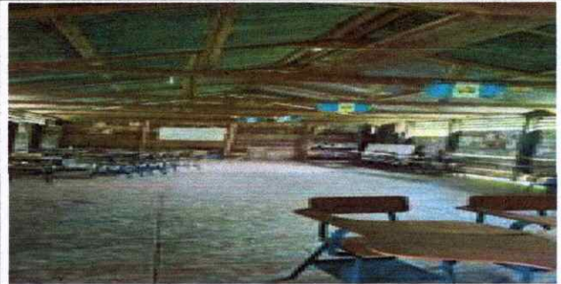
REMOZAMIENTO DEL PISO
