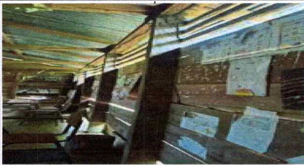
REMOZAMIENTO DE PARED
