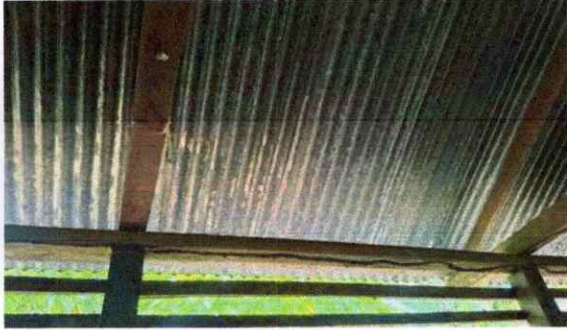
REMOZAMIENTO DEL TECHO DEL AULA DE CLASES
