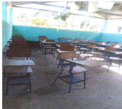
Foto 4: Sustitucion de piso de torta de concreto.
