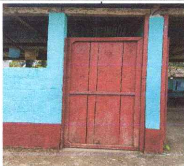
Foto 3: Sustitucion de puerta.
