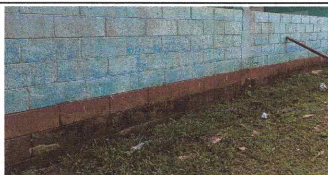
Foto 5: Pintura de muros exteriores e interiores.
