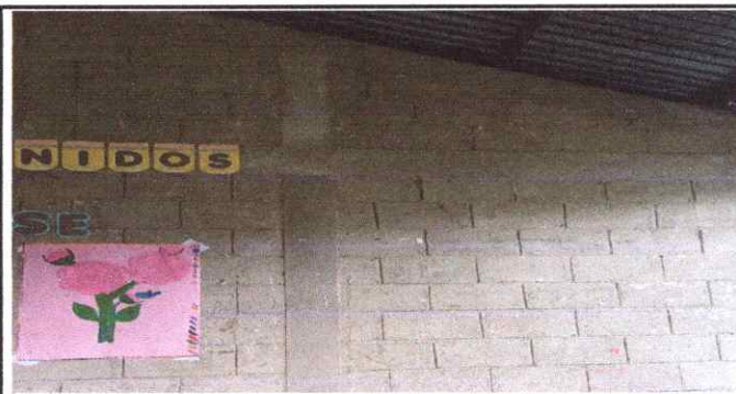
Foto 6: Repello en muro.
