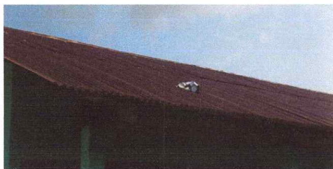
Foto 1: Sustitucion de lámina por lamina troquelada aluzinc calibre 26.
