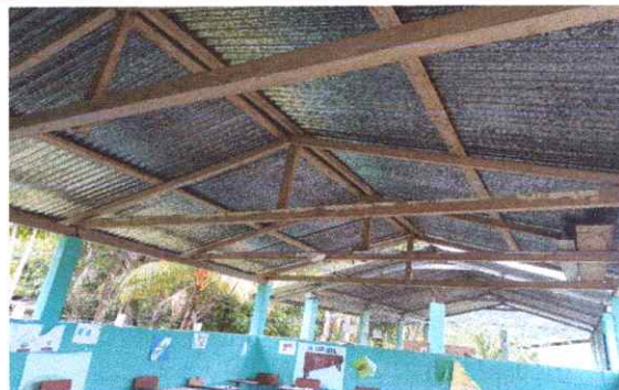
Foto 2: Sustiticion de estructura de soporte de madera, por meta.
