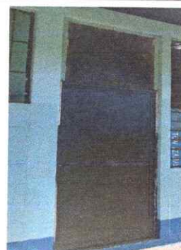
Foto 4: Mantenimiento a estructura de puertas (lijado, cambio de tubo, cepillado, sujecciones, aplicación de pintura)
