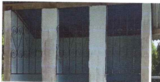
Foto 7: Sustrucción a balcones de metal.
