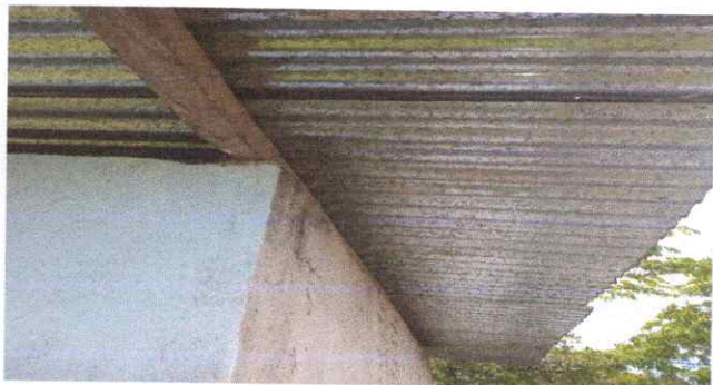
Foto 1: Sustrucción de lámina, por lámina troquelada aluzcinc calibre 26 en baños.
