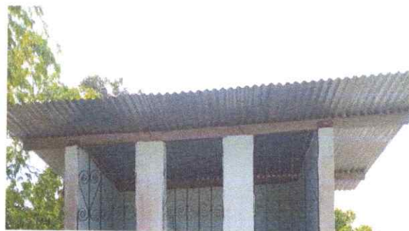
Foto 2: Mantenimiento a estructura de soporte de madera, por metal en baños.
