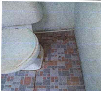
Foto 9: Sustrucción de piso de gránito
