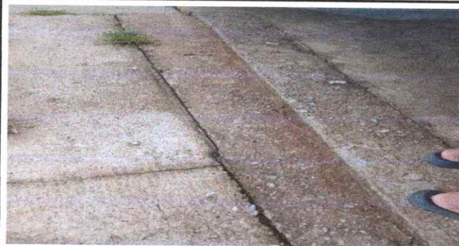
Foto 10: Reparación de banqueta de concreto
