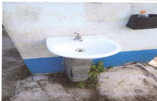
Foto 14: Sustitución de lavamanos
