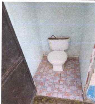
Foto 13: Sustitución de inodoros
