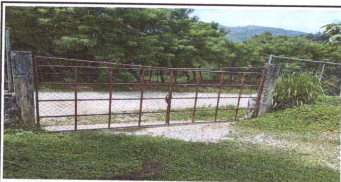
Foto 5: Mantenimiento a Portón de Metal de Ingreso
