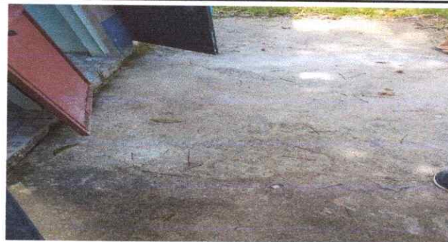
Foto 8: Sustrucción de piso de torta de concreto
