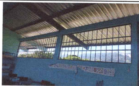
Foto 6: Mantenimiento a balcones de metal
