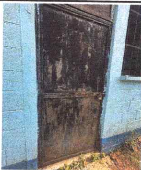
Foto 3: Sustrucción de Puertas
