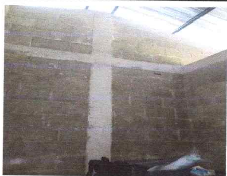
Foto 11: Pintura en muros exteriores e interiores
