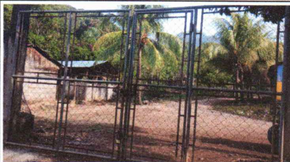
Foto 2: SUSTITUCION DE PORTON DE METAL
