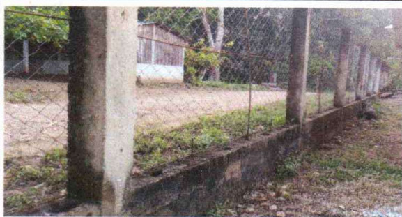
Foto1: REPARACION DE MURO PERIMETRAL DE BLOCK CON TUBO HG Y MALLA GALVANIZADA
