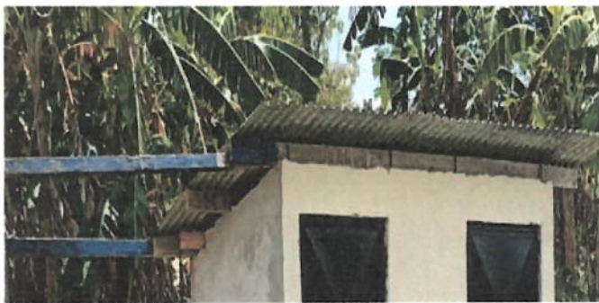
Foto 3: Sustitución de estructura de soporte de madera, por metal (BAÑOS)
