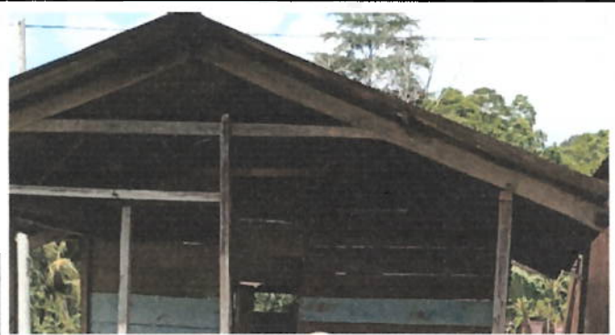
Foto 2: Sustitución de estructura de soporte de madera, por metal (COCINA)
