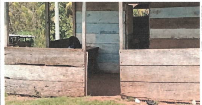
Foto 4: REPARACIÓN DE CIRCULACIÓN CON MALLA GALVANIZADA
