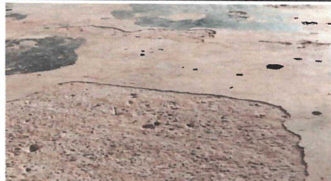
Foto 8: Sustitución de piso de torta de concreto
