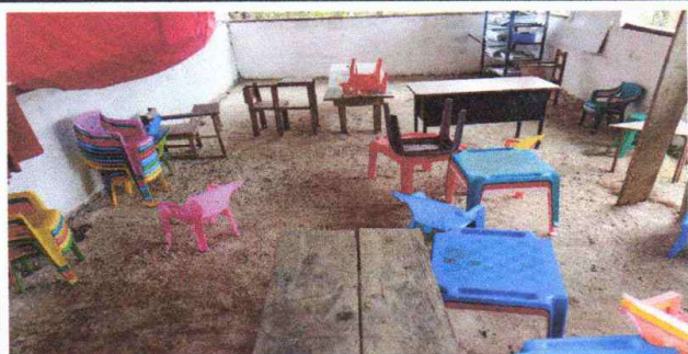
Foto 5: Reparación de piso de torta de concreto
