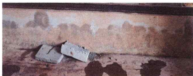
Foto 3: Reparación de paredes de block, circulación del aula
