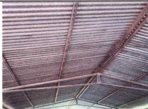
Foto 2: reparación a estructura de soporte de metal lijado y pintura
