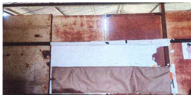
Foto 4: Sustitución de paneles de metal por balcones tipo barrote
