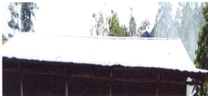
Foto1:Sustitución de techo de manaca por lámina aluzinc calibre 26
