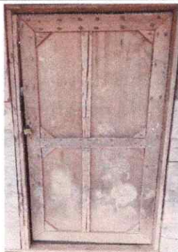
Foto 3: Sustitución de puerta (2.10m de alto * 1.00m de ancho)
