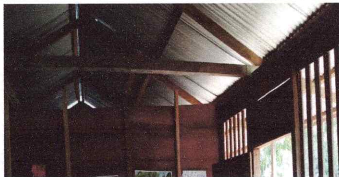
Foto 2: Sustitución de estructura de soporte de metal
