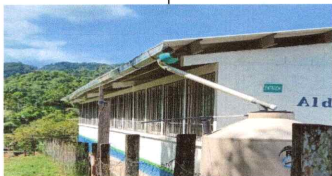
Foto 3: SUSTITUCION DE CANAL DE METAL
