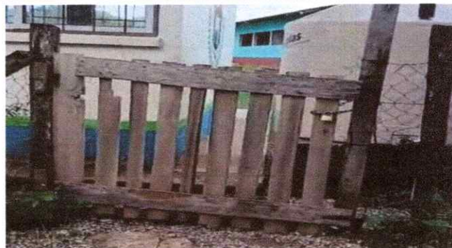
Foto 2: Sustrucción portón de madera por Metal
