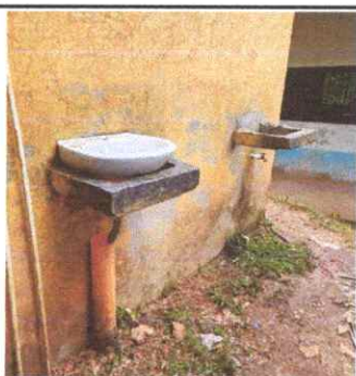
Foto 5: Sustitución de lavamanos por una pileta de concreto
