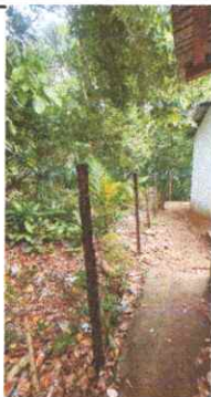
Foto 1: sustitución de alambre de pua, por block, tubo hg y malla galvanizada
