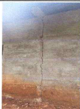
Foto 3: Sellado de grietas y fisuras en muros
