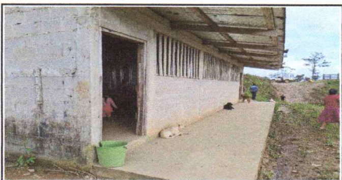
Foto 5: Pintura en muros exteriores e interiores
