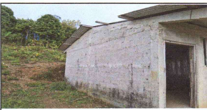
Foto 6: Repello en Muros Exteriores e interiores
