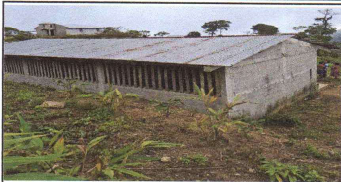
Foto 1: Sustrucción de lámina, por lámina troquelada calibre 26
