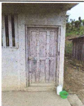
Foto 3: Sustrucción de Puertas
