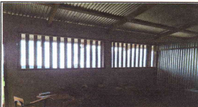
Foto 4: Fabricación e instalación de ventana-balcón de metal
