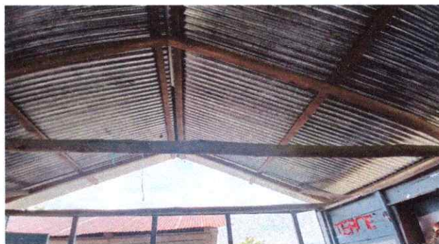
Foto 2: Sustitución de estructura de soporte de metal
