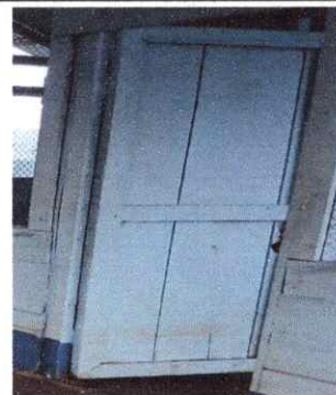
Foto 4: Sustitución de puerta de (2.10m de alto *1.00 m ancho)
