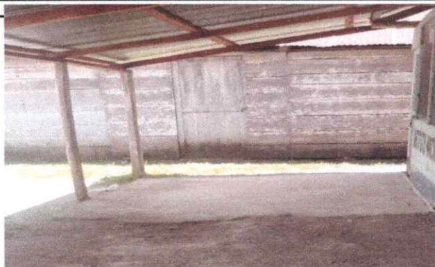
Foto 3: Sustitución de piso de cemento líquido
