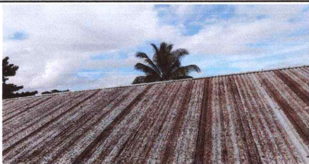
Foto1: SUSTITUCIÓN DE LAMINAS POR LÁMINAS TROQUELADAS ALUZINC CALIBRE 26, COLOR ROJO
