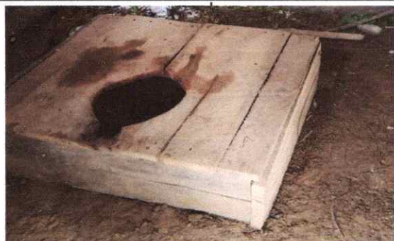
Foto 4: SUSTITUCIÓN DE SANITARIO
