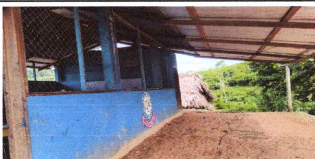
Foto2: Sustitución de torta de concreto por ceramica
