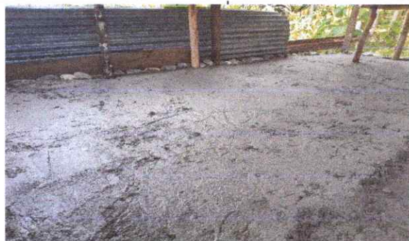
Foto 3: Sustitución de piso de torta de concreto.
