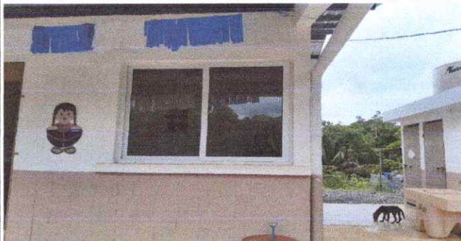
Foto 4: Sustitución de Pila plástica de dos lavaderos por Pila de cemento mas azulejo de 2 mt de Largo por 1 mt de Alto.
