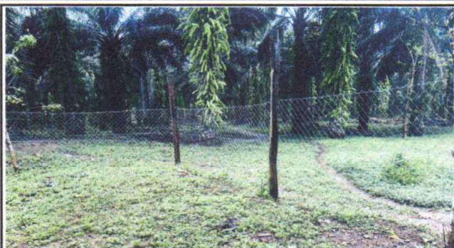
Foto 1: Sustrucción de malla, y reparación de muro perimetral con block con tubo hg y malla galvanizada.
