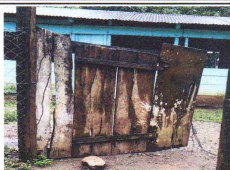
Foto 2: Sustrucción de portón de madera por metal
