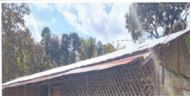
Foto 3: Sustitucion de Laminas traqueladas
