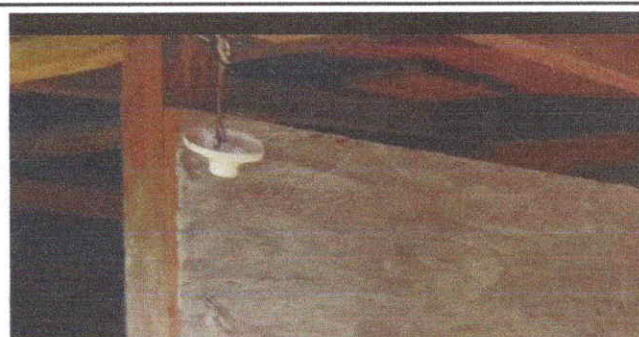
Foto 6: Sustitucion de sistema electrico
