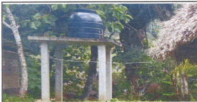
Foto 5: Sustitucion de tuberia por pvc de 1/2
