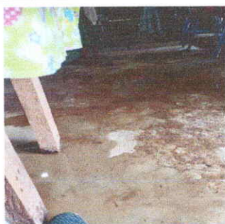
Foto1: SUSTITUCION DE LA TORTA DE CEMENTO POR AZULEJO
