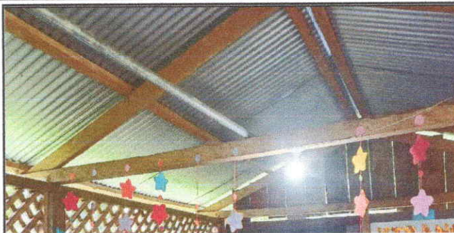
Foto 2: Sustitucion de bases por costaneras
