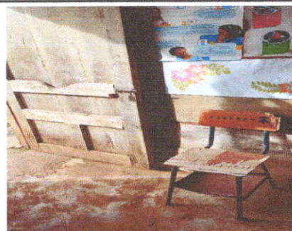
Foto 4: Sustitucion de puertas de madera por metal
