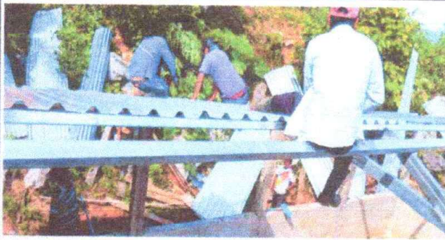
FOTO 1 SUSTITUCIÓN DE LÁMINA, POR TROQUELA ALUZINC 26
