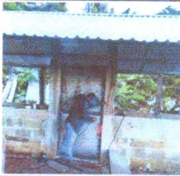
FOTO: FABRICACIÓN E INSTALACIÓN DE PUERTA DE METAL
