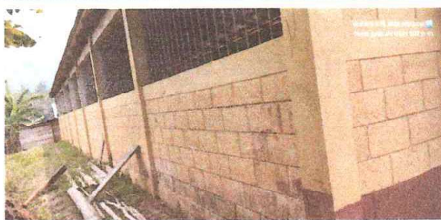
Foto 4: Pintura en muros exteriores e interiores
