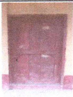
Foto 3: Sustitución de puerta
