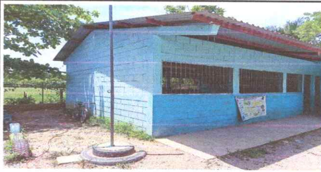
Foto 3: Pintura de muros interiores y exteriores
