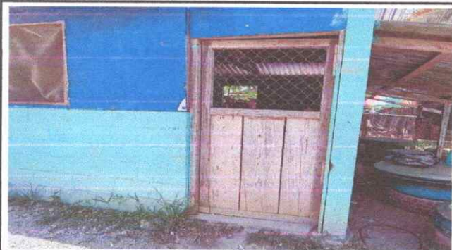
Foto 1: Sustrucción de puerta de madera por metal
