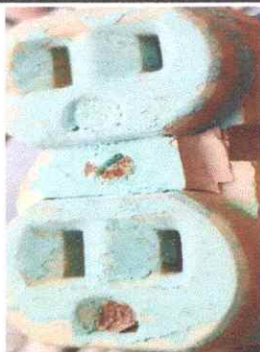
Foto 3: Sustrucción de plafonera
