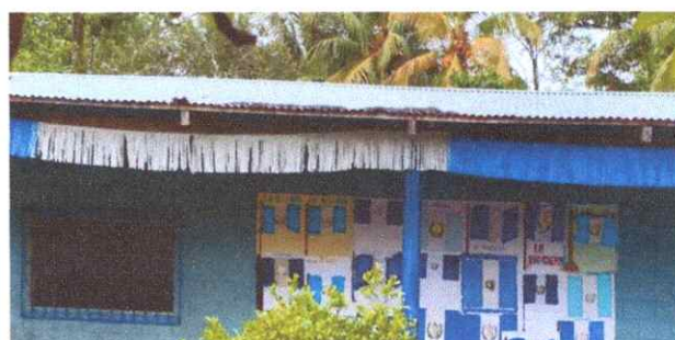
Foto 2: Sustrucción de lámina, por lámina troquelada aluzinc calibre 26
