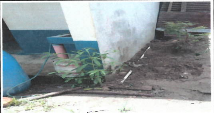
Foto 4: Sustitución de tubería de Metal en línea principal de agua
