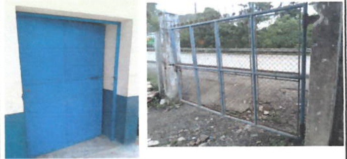
Foto 2: Sustitución de Puerta de metal y Sustitución de Portón de Metal
