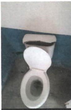
Foto 3: Sustitución de Inodoros completos
