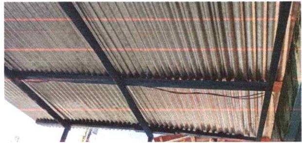
Foto 2: Sustrucción de estructura de madera por metal
