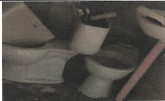
Foto 3: Sustitución inodoro y lavamanos
