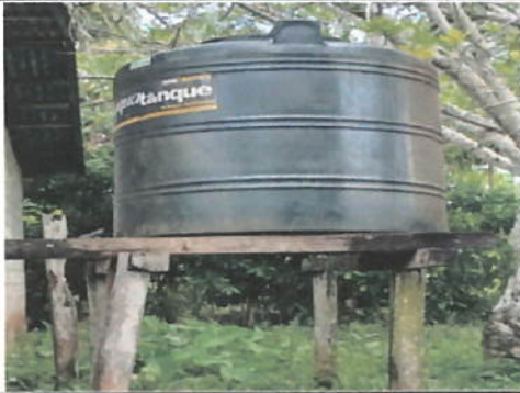
Foto 1: sustitución de soporte de madera por soporte de concreto para cisterna
