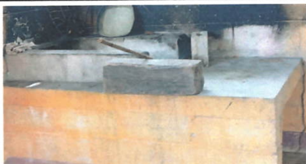
Foto 5: Reparación Hornilla de estufa rural
