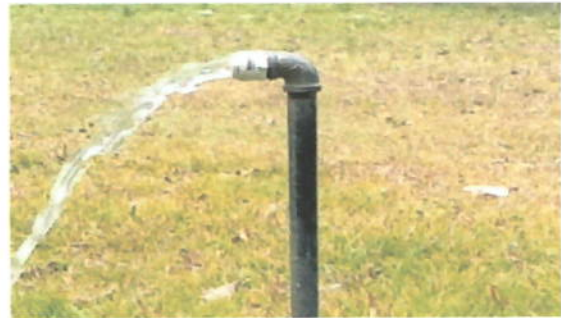
Foto 4: Sustitución de llave de chorro
