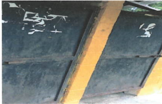
Foto 1: Sustitución de puertas de servicios sanitarios
