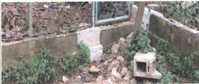
Foto 5: Reparación de muro perimetral de block con tubo hg y malla galvanizada
