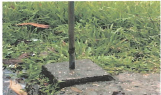
Foto 6: Reparación base de concreto para tubo de chorro
