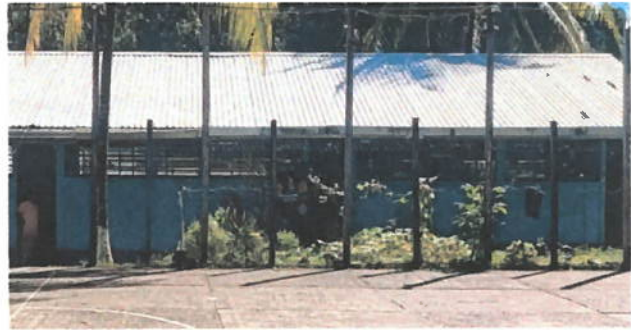
Foto 2: Reparación de tela de cancha por malla galvanizada
