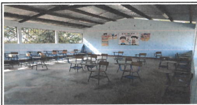
Foto 4: Fabricación e instalación de división corredisa de plywood en Aula
