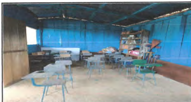
Foto 5: Sustitución de piso de cemento de concreto a liquido
