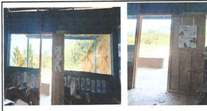
Foto 4: Fabricación e Instalación de Balcones de Hierro y Sustitución de Puerta de Madera, por Metal
