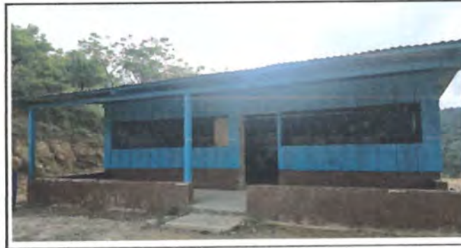
Foto 6: Pintura en muros exteriores e interiores
