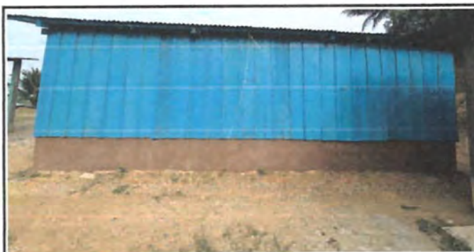
Foto 3: Ampliación y Refuerzo Estructural en Aula.
