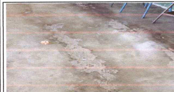
Foto 3: Sustitución de cemento alisado por piso cerámico
