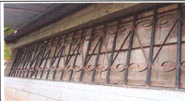
Foto 2: Sustitución de ventanas por ventanas de pvc más vidrio y mantenimiento a balcones de metal
