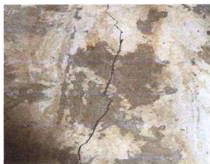
Foto 4: Sustrucción de piso de torta de concreto
