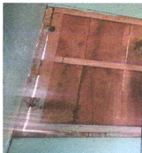
Foto 5: Sustrucción de ventanas de madera a metal
