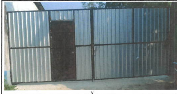
Foto 6: Mantenimiento a estructura (lijado, cambio de tubo , cepillado, sujeciones, aplicación de pintura)
