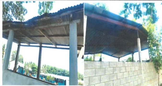
Foto1: Sustitución de lámina, por lámina troquelada aluzinc calibre 26 en Aula y Cocina
