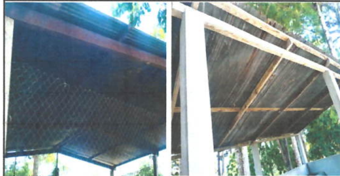
Foto 2: Mantenimiento a estructura de soporte de metal en Aula y Sustitución de Estructura de Soporte de Madera por Metal
