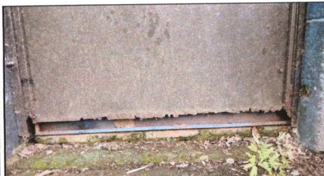
Foto 3: SUSTITUCION DE PUERTA DE METAL (2.00M DE ALTO *1.00M DE ANCHO
