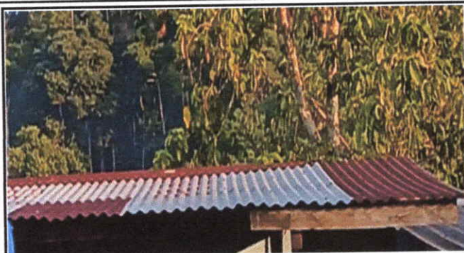
Foto 1: SUSTITUCION DE LÁMINA, POR LÁMINA TROQUELADA ALUZINC CALIBRE 26
