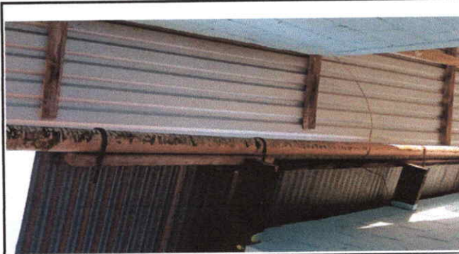
Foto 4: SUSTITUCION DE CANALES PVC
