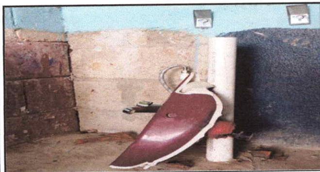
Foto 5: SUSTITUCION DE LAVAMANOS
