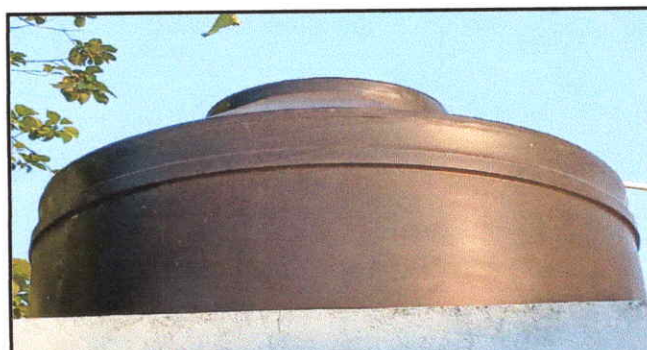
Foto 6: SUSTITUCION DE DEPOSITO DE AGUA 2,500 LT
