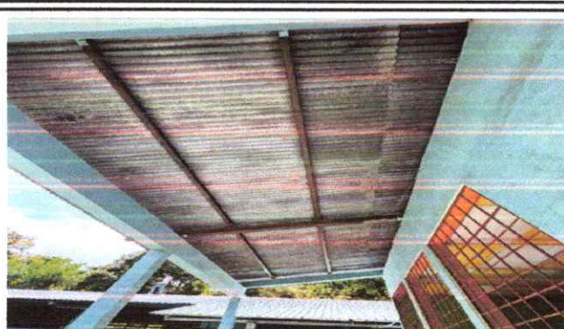
Foto 2: Mantenimiento a estructura de soporte de metal
