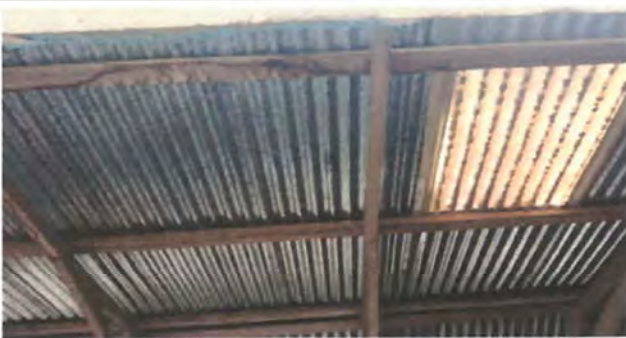
Foto 3: Sustrucción de estructura de soporte de madera, por metal en Aula 1
