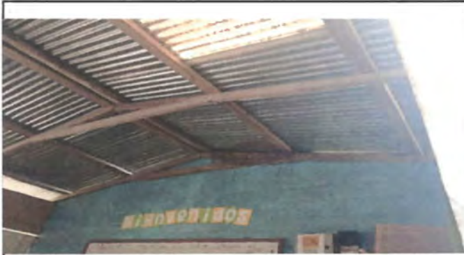
FOTO 1. Sustrucción de Lamina, por Lamina Troquelada Aluzin Calibre 26 en Aula 1
