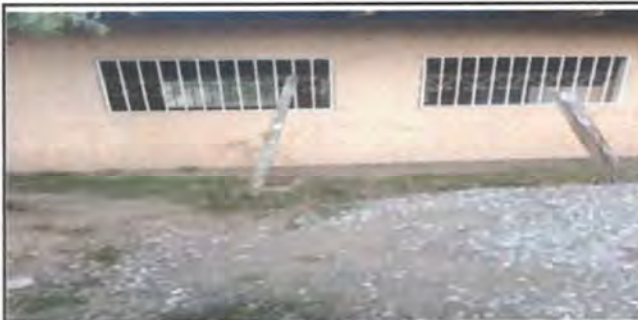
FOTO 5 : Reparación de muro perimetral de block con tubo hg y malla galvanizada, soleras intermedias y columnas.
