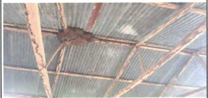
Foto 4: Sustrucción de estructura de soporte de madera, por metal en Salón
