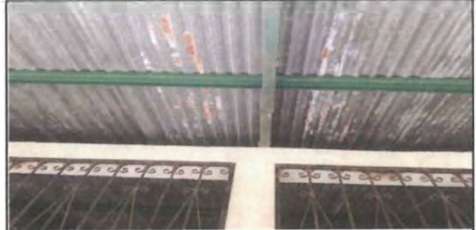
Foto 2: Sustrucción de Lamina, por Lamina Troquelada Aluzin Calibre 26 en Aula 2
