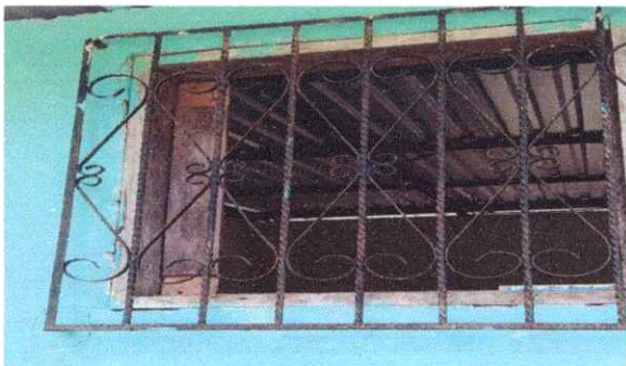
Foto1:Sustitución de balcones de metal
