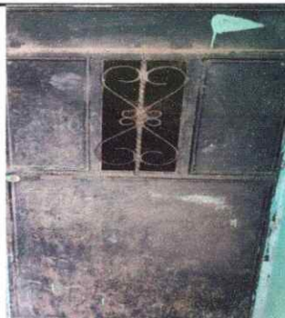
Foto 2: Sustitución de puerta (2.10m de alto * 1.00m de ancho)
