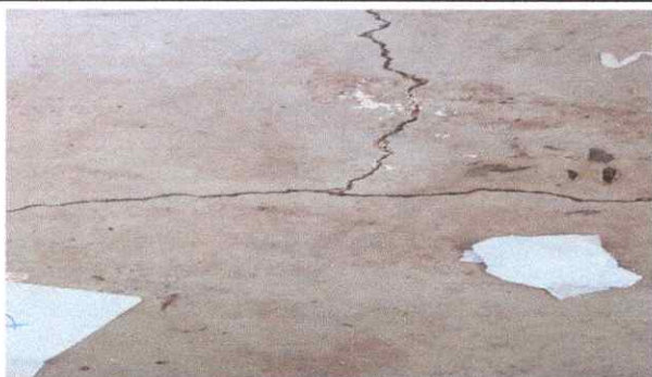
Foto 3: Sustitución de piso de granito
