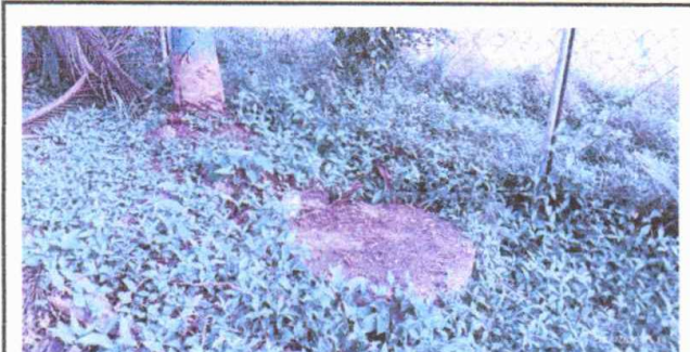
Foto 3: Limpieza de fosa séptica
