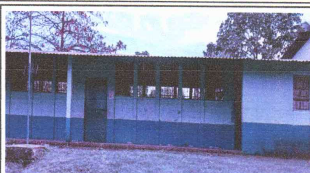
Foto 2: Pintura en muros interiores e exteriores
