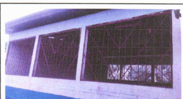
Foto 6: Mantenimiento a balcones de metal
