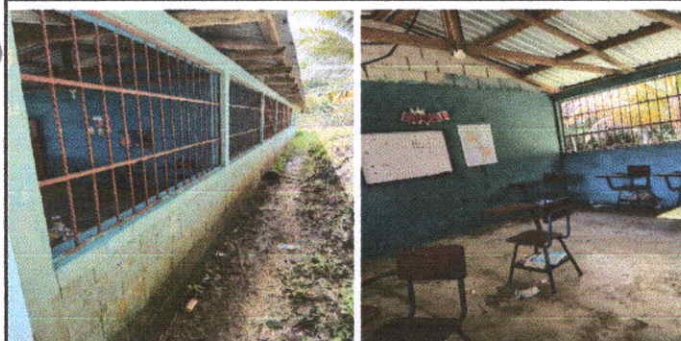
Foto 5: pinturas en muros exteriores e interiores
