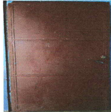
Foto 2: sustitución de puertas
