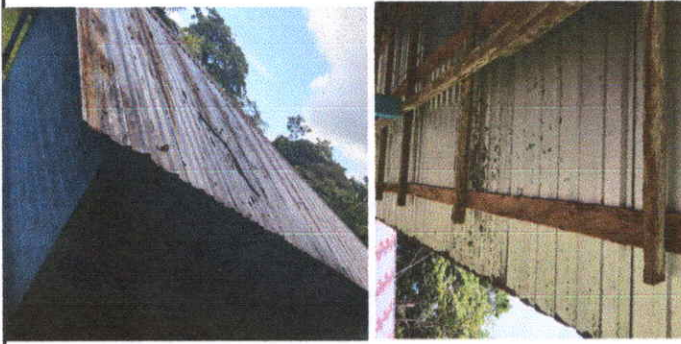
Foto 1: Sustitución de láminas, por láminas
