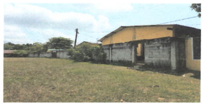
Foto 4: Reparación de muro perimetral de block
