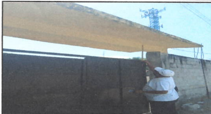
Foto 8: Fabricación e Instalación de Complemento de Portón de Metal de Ingreso
