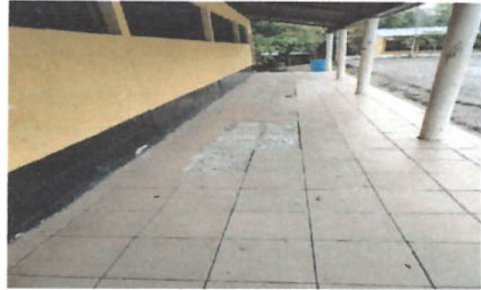
Foto 2: Sustitución de piso cerámico
