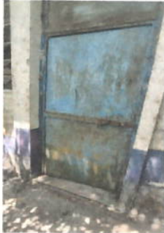
Foto1: Sustitución de puertas
