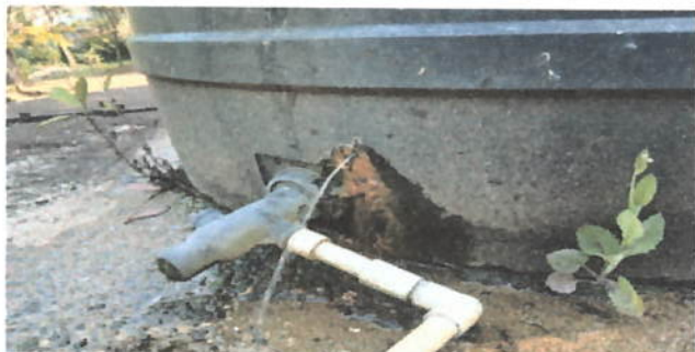
Foto 7: Sustitución de depósito de agua 1100 lt
