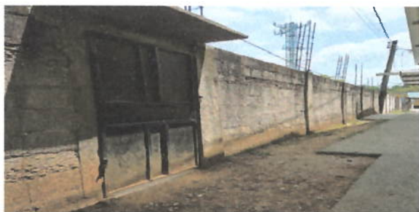
Foto 9: : Repello en muro
