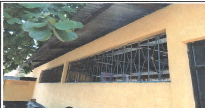
Foto 10: Mantenimiento a balcones de metal
