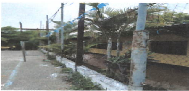
Foto 5: Reparación de tubo hg y malla galvanizada
