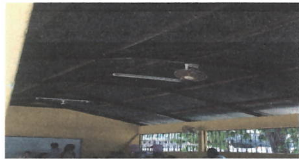
Foto 6: Reparación de Sistema Eléctrico
