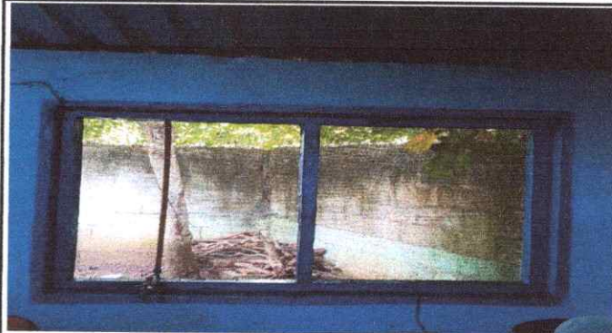
Foto 2: Sustitución de ventana de madera por metal más vidrio
