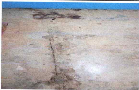
Foto 3: Sustitución de piso de torta de concreto
