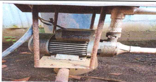
Foto 6: Sustitución de bomba de agua
