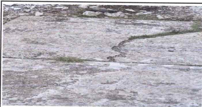
Foto 5: Reparación de planchas de concreto de patio
