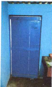
Foto1:Sustitución de Puertas de Madera por Metal
