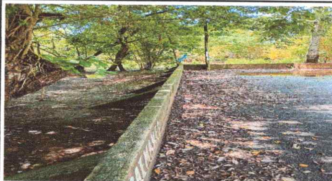
Foto 4: Reparación de planchas de concreto de patio
