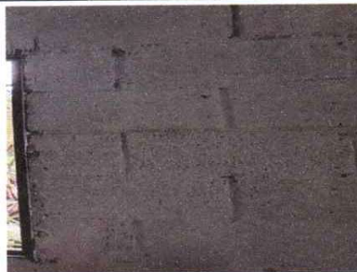
Foto 2: Repello en muro
