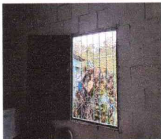
Foto 3: Sustrutcton de estructura de metal de ventanas por Ventanas PVC
