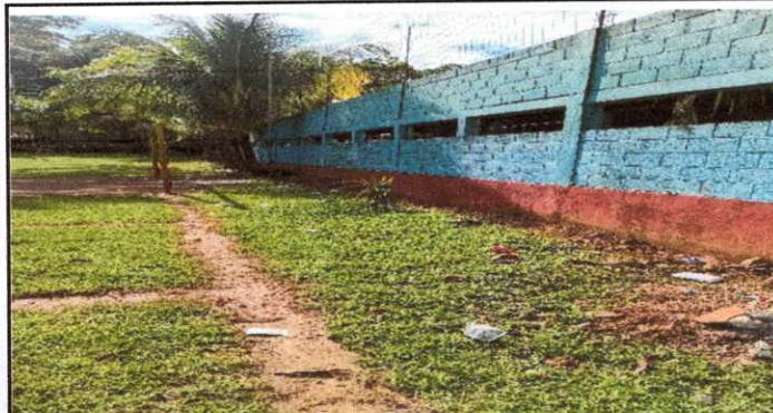
Foto 1: REFORZAMIENTO DE COLUMNAS DEL MURO PERIMETRAL
