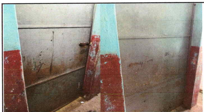
Foto 4: SUSTITUCIÓN DE PUERTAS DE METAL
