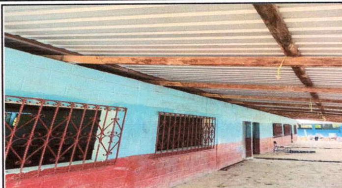
Foto 2: SUSTITUCIÓN DE TECHO Y ESTRUCTURA DE SOPORTE DE MADERA POR ESTRUCTURA DE METAL DE CORREDOR
