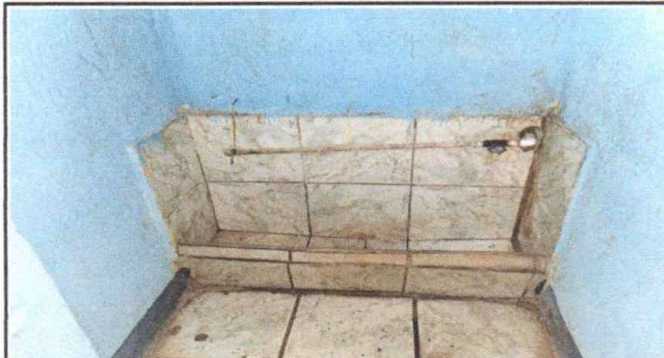
Foto 4: Reparación de Mingitorio
