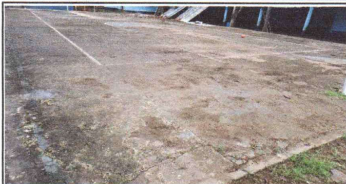
Foto 1: Sustitución de Piso de Torta de Concreto en Cancha
