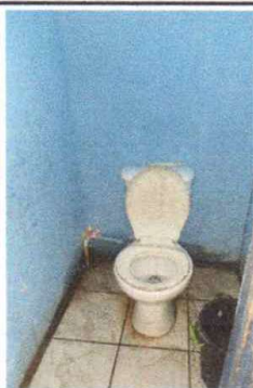
Foto 3: Sustitución de Inodoros
